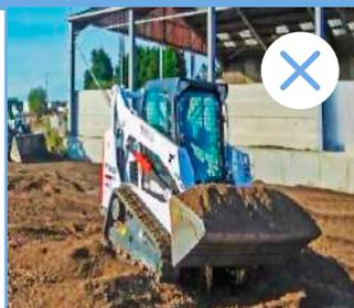
**Uso de vehículo con cabina con filtrado de aire. Humectación del material.**
