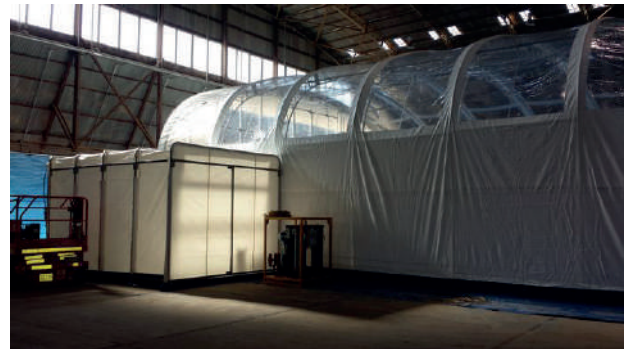
Fig. 5.2. Distintos ejemplos de cerramientos a presión negativa (Fuente: www.duroair.com )
